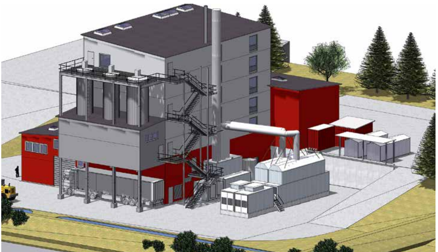
Die 3D-Ansicht zeigt ein Beispiel einer 3 t/h-Klärschlamm-Monoverbrennungsanlage komplett mit Trockner und Verwaltungsgebäude auf einer Fläche von rund 45 m x 55 m.
