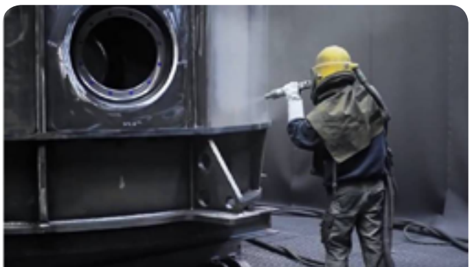
Sandstrahlen zur Lackiervorbereitung
