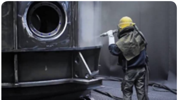
Sandstrahlen zur Lackiervorbereitung
