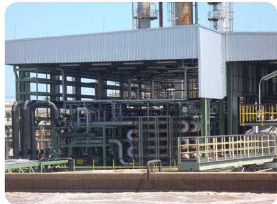
Zum Beispiel **IRPC Public Company Limited, Rayong Province / TH** – Raffinerie und petrochemische Produktentwicklung: Modernisierung und Leistungssteigerung einer konventionellen Kläranlage durch einen BIOMEMBRAT®-Hochleistungs-MBR bei gleichzeitiger Platzeinsparung.
