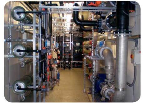
Zum Beispiel **DUGAS – Dubai Natural Gas Co., Ltd. in Dubai / UAE** – Wasserrecycling durch eine MBR/RO-Kombination von WEHRLE: Wiederverwendung des behandelten Abwassers mit einem BSB/CSB-Verhältnis im Zulauf von < 10% als demineralisiertes Wasser. Die kompakte Containeranlage erlaubt eine einfache und schnelle Montage vor Ort!
