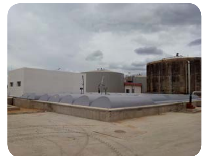
Beispiel: Kläranlage Badajoz / ES mit einem BIOMOX®-CFR
